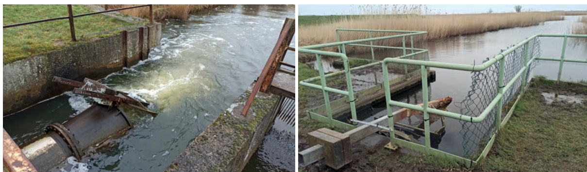
Abbildung 6.44: Zwei für Hechte unpassierbare Wanderhindernisse an einer der zahlreichen technischen Einrichtungen zur Wasserabflussregulierung an den Bodden. Links ein Ausfluss eines Pumpwerks, das nur beim aktiven Pumpen geöffnet ist, rechts ein Querbauwerk mit Klappensystem, das nur bei starkem Abfluss offen ist.
