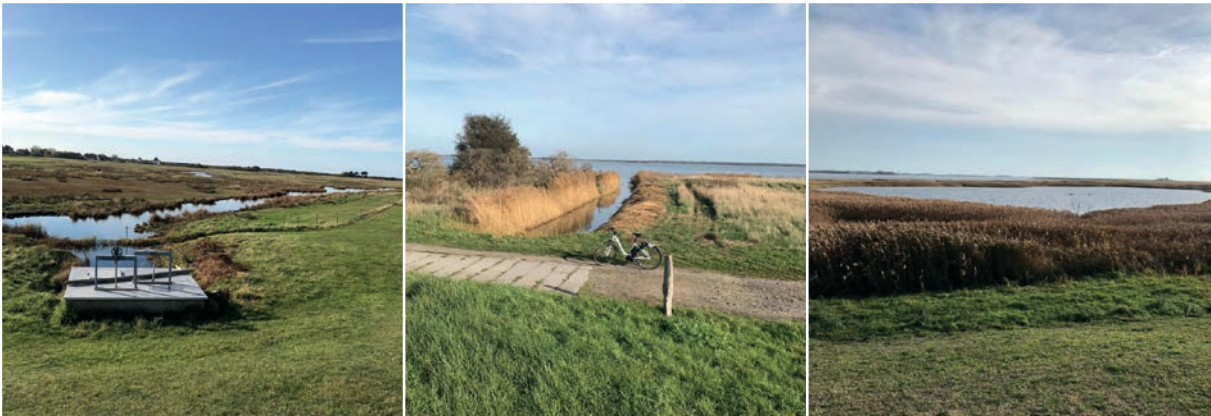
Abbildung 1.55: Querverbau eines Grabensystems auf Hiddensee. Durch die technische Einrichtung ist das Einwandern in den See für Hechte nicht mehr möglich.
