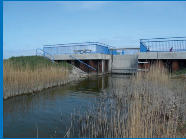
Abbildung 5 in Box 1.3: Geöffnetes Sperrwerk im frühen Mai 2022.
