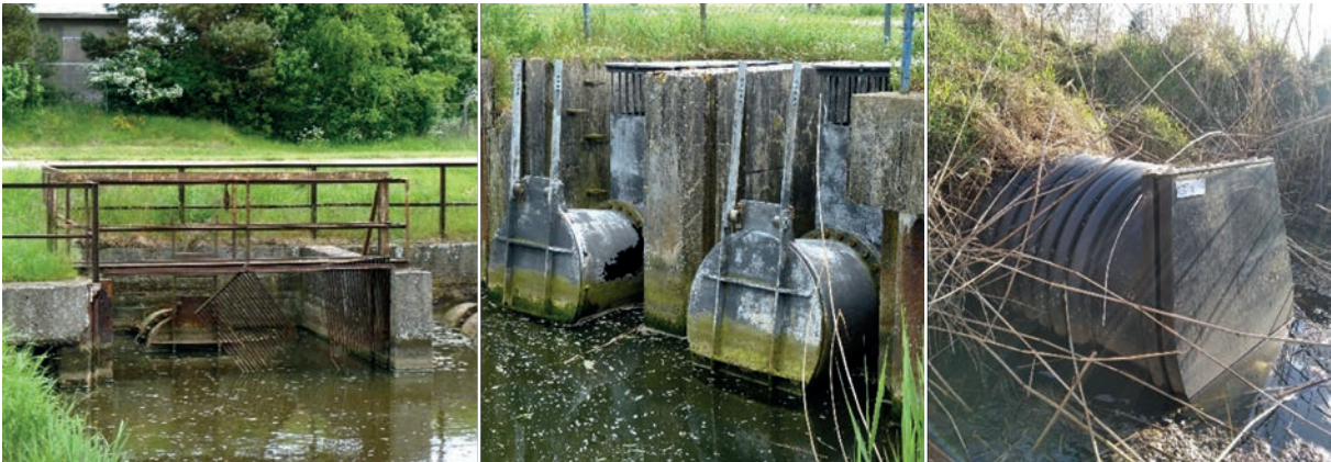
Abbildung 1.56: Beispiele für Klappensysteme, die einen Aufstieg von Hechten während der Laichzeit in ausgesüßte Gräben und Bäche um Rügen verhindert.
